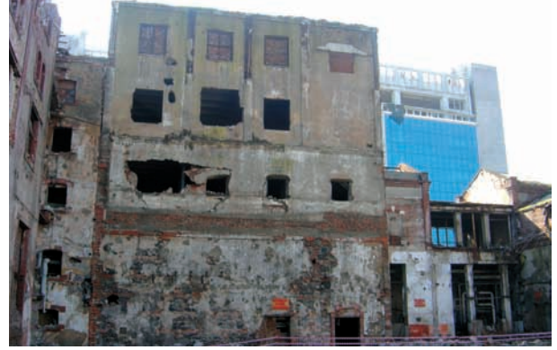
Res.10- D blok yapısı genel görünüm
