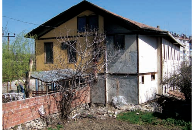
Res.25- Şamlılar Çeltik Fabrikası, kuzeybatı cephesi
