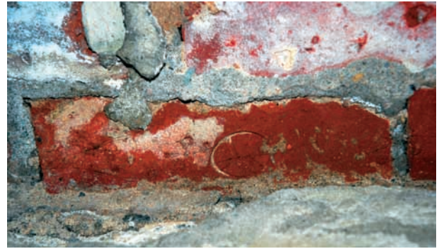
Res.12- Bomonti Bira Fabrikası'ndaki yağma yapılarda kullanılan Osmanlıca damgalı tuğlalardan bir örnek
