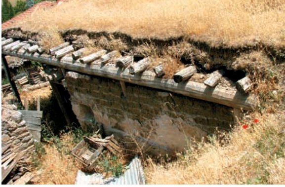
Res.13- Düz dam yapım sistemi
