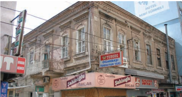
Res.12- Kuruköprü Mahallesi'nde geleneksel konut (O34.B9.579)
