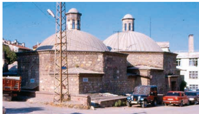
Res.28- Arabapazarı Çifte Hamamı güney görünüşü
