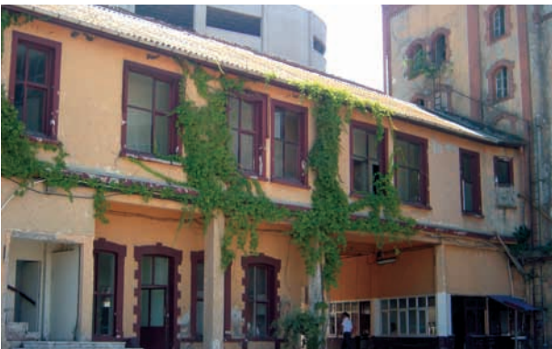
Res.8- B blok yapısı genel görünüm
