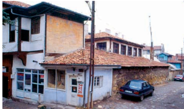
Res.10- İsfendiyar Bey Hamamı güney görünüşü
