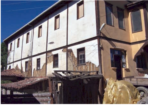
Res.26- Şamlılar Çeltik Fabrikası, güneybatı cephesi
