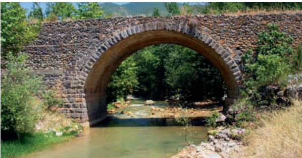
Res.12- Sabunsuyu Köprüsü
