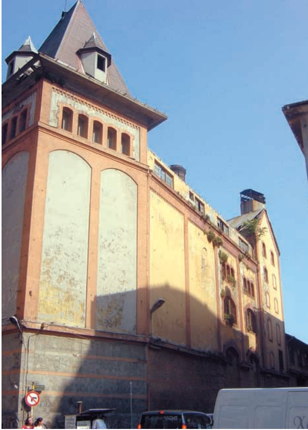
Res.9- C blok yapısı genel görünüm
