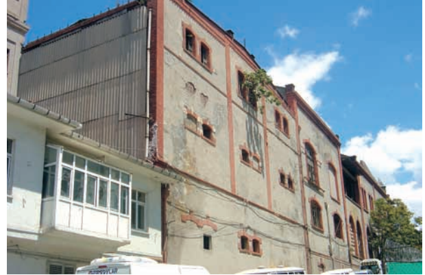
Res.11a- F blok yapısı genel görünüm
