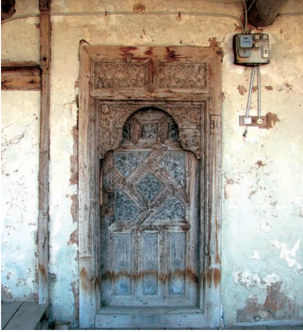
Res.27- Hacı Süleyman Evi kapı detayı
