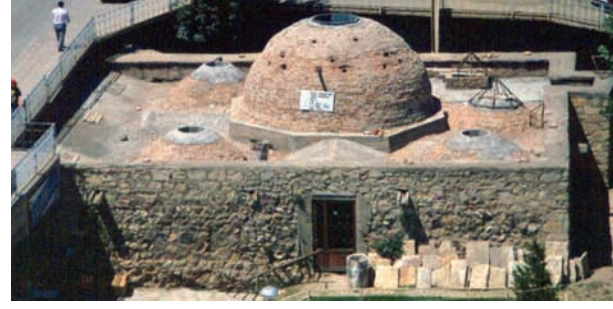
Res.2- Firenksah Hamamı'nın restorasyon öncesine ait eski fotoğrafı (Kastamonu Müzesi Arşivi)
