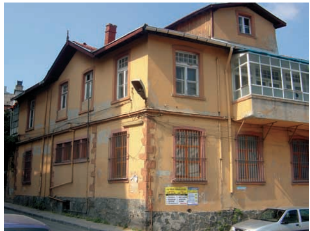
Res.7- A blok yapısı genel görünüm
