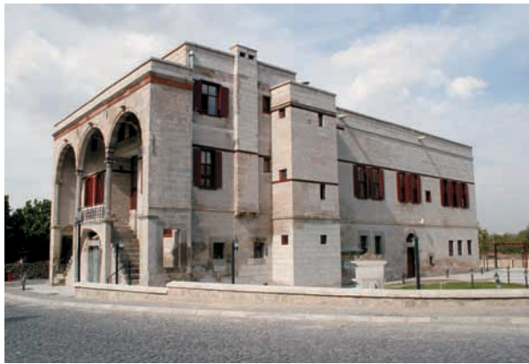
Res.19a- Talas geleneksel doku cephe örneği
