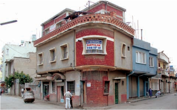
Res.34- Beşiktaş Mahallesi'nde sıklıkla rastlanan 1940-1960 dönemine ait yapılardan biri
